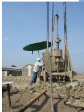
給水設備(井戸掘削中)
